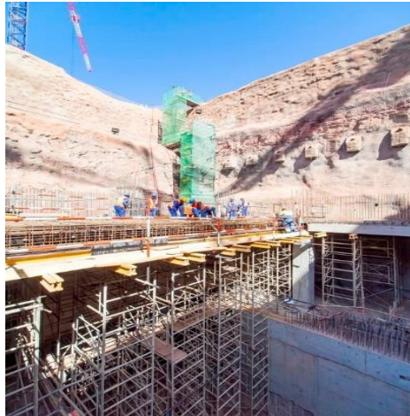
أعمال انشاء المعمل الكهربائي
