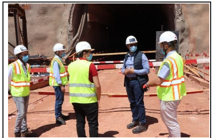
Visite du chantier de creusement de la galerie basse pression
