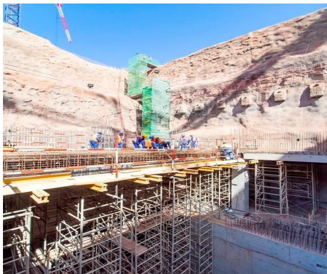
Travaux de construction de l'usine de la STEP Abdelmoumen
